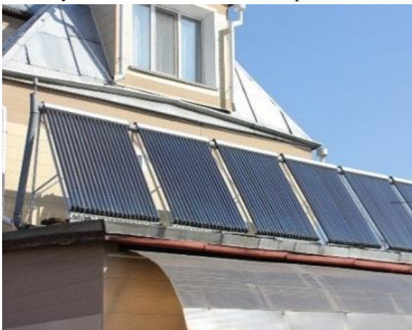
Рис.4. Группа солнечных коллекторов для энергообеспечения жилого дома (расположение - крыша).
