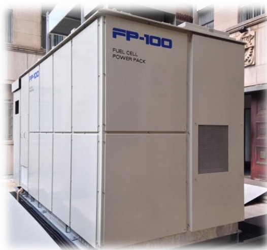
Рис. 2. Топливный элемент «FP-100» мощностью 100 кВт производства «Fuji Electric»
