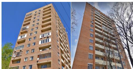
Рис.5. Вид на здание с южной и западной сторон.
